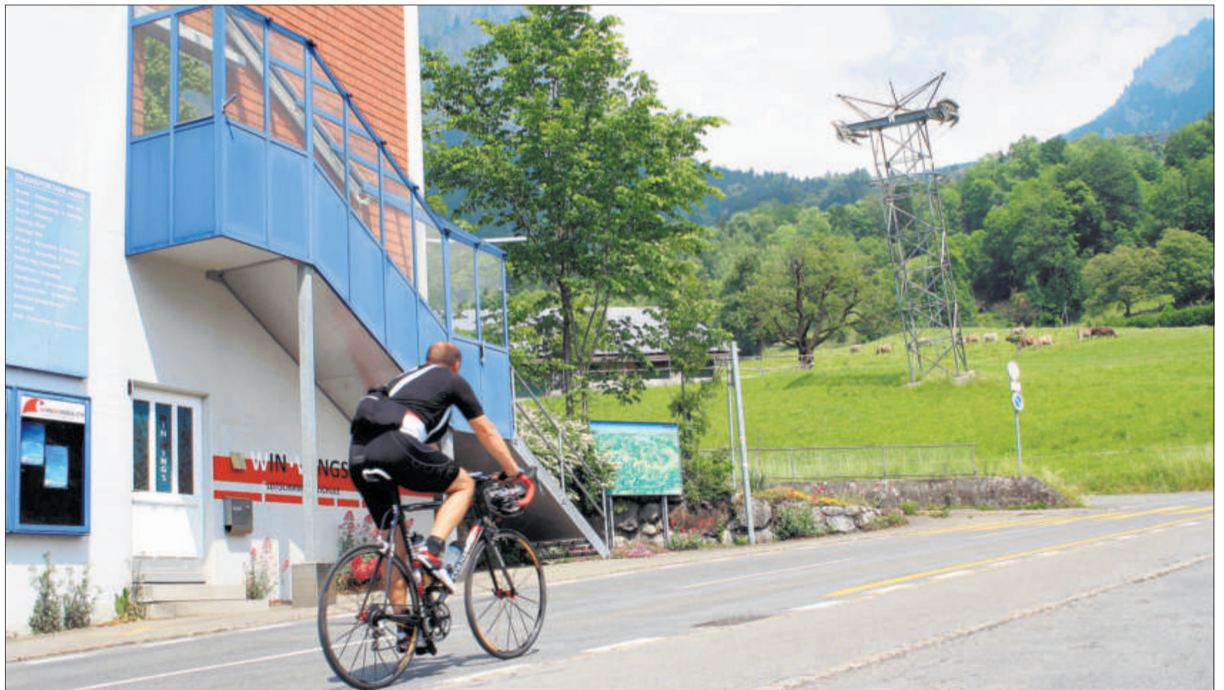
Ab Mitte Juni werden die Masten der Rotenfluh-Seilbahn abgerissen.
