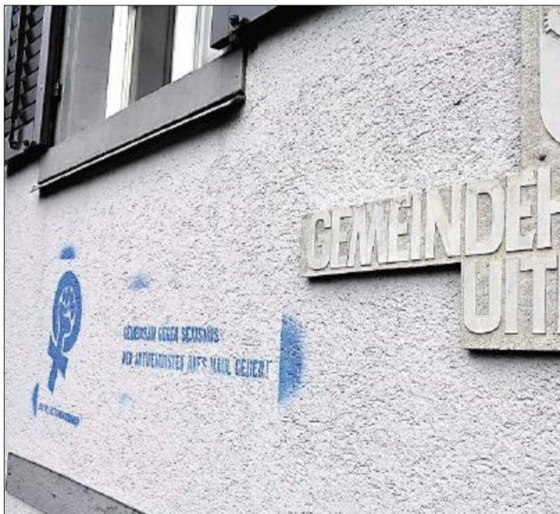
Verunstaltete Fassade des Gemeindehauses Uetikon. (Matthias Kessler)
